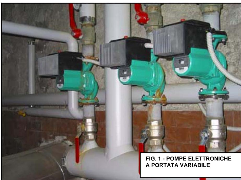
**FIG. 1 - POMPE ELETTRONICHE A PORTATA VARIABILE**
